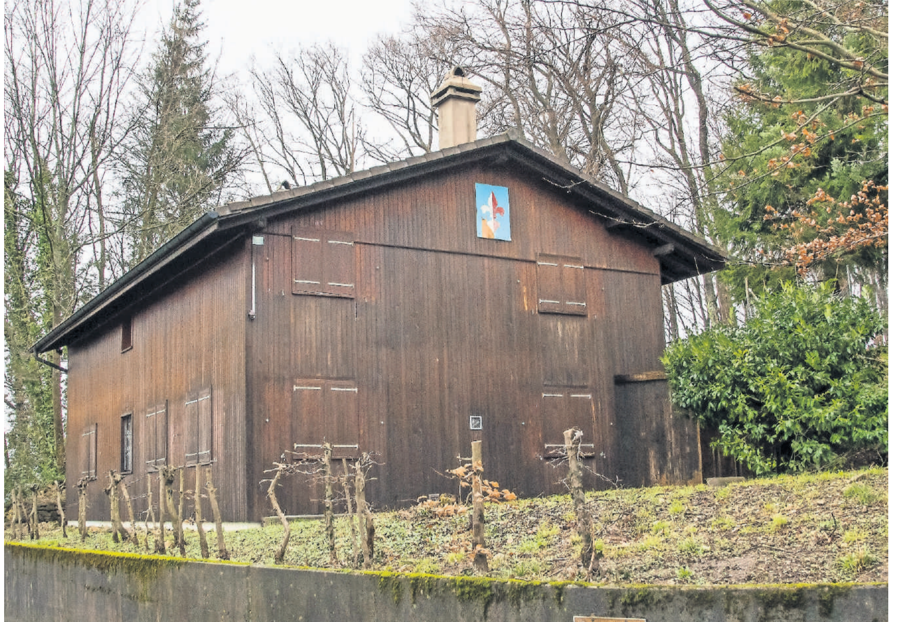
Das Pfadihaus wurde 1940 gebaut und zuletzt 1972 umfassend renoviert.
